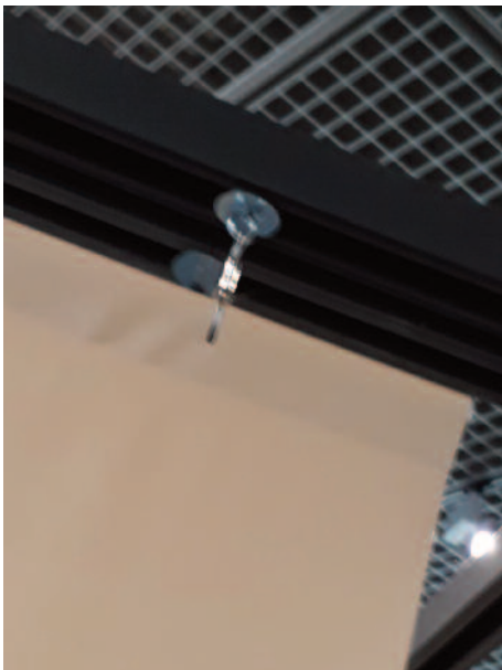
Metall-Plättchen verbindet die doppelten Rahmen miteinander
