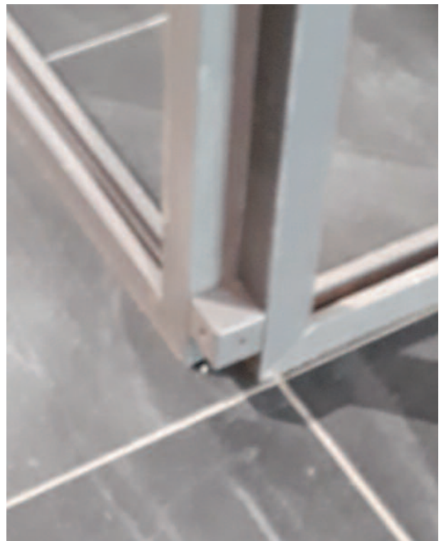
Eckverbindung einfache Rahmen / unten
